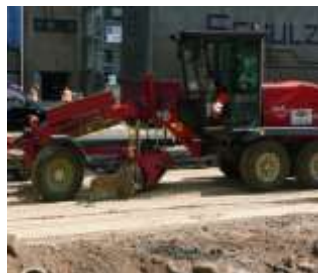
Tief- und Straßenbau
